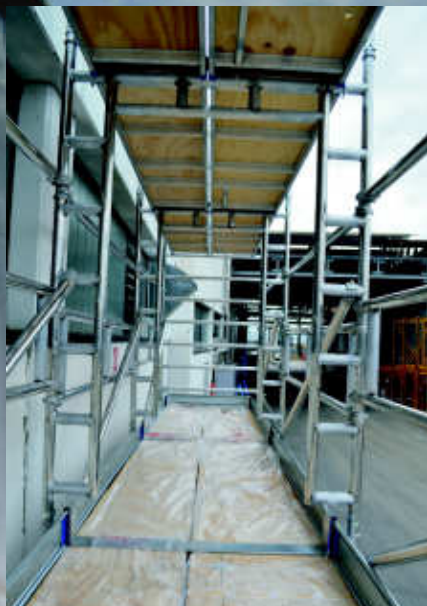
AW2 Particolare passaggio intermedio Detail Intermediate passage
